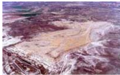
Imagen 5: Vista del vertedero de Valdemingómez ya sellado
